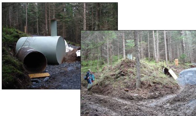
Abb.: 9 li. Bau der Fuchsbaubühne, re. Fuchsbau überschüttet
