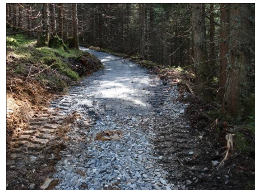
Abb.: 15 Wegebau, Frostkoffer und Grädermaterial
